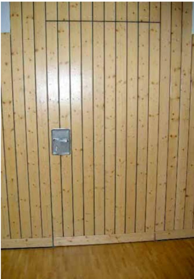
Bild 47: Bündig angeordnete Tür
