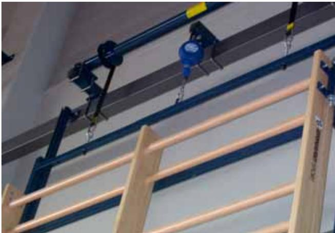
Bild 99: Fangvorrichtung an hochziehbaren Sportgeräten
