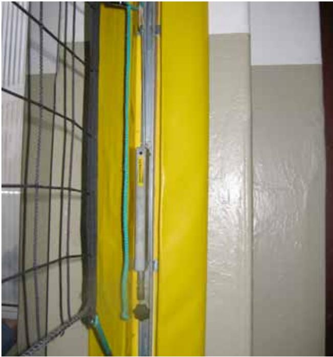
Bild 46: Wandschienen mit beidseitigen Prallschutzkeilen gelten als ebenflächig.
