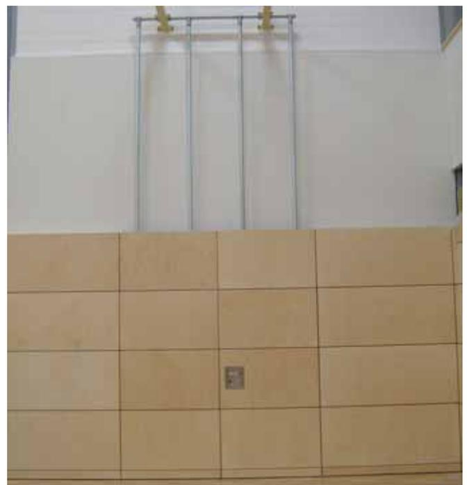
Bild 68: Durch Prallwandtore gesicherte Kletterstangen
