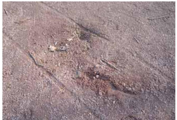
Bild 103: Schadhafter Tennenbelag
