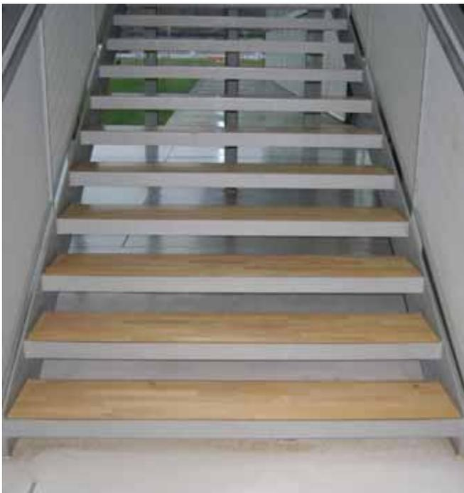
Bild 18: Nichtbarrierefreie Treppe ohne Setzstufen mit Untertritt
