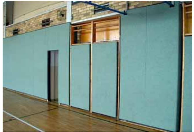
Bild 71: Aushängbare Prallwandabdeckung für Sprossenwände
