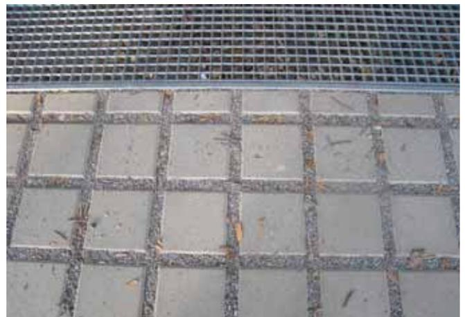
Bild 6: Ungeeignete Pflasterung vor dem Eingangsbereich führt zum Splitt eintrag in das Gebäude
