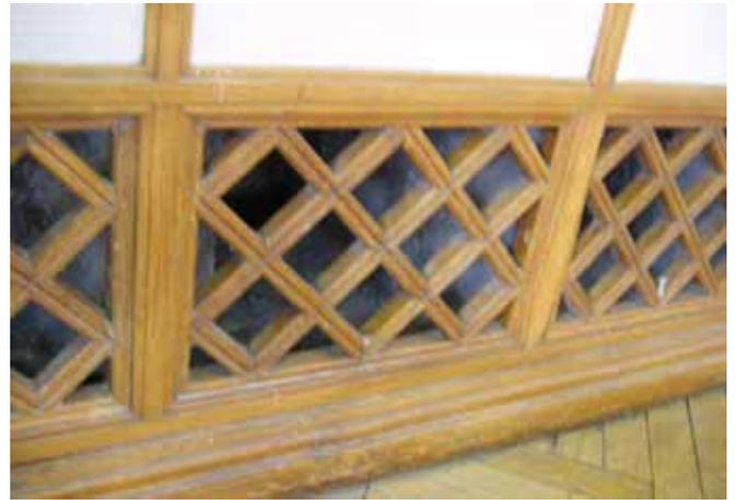
Bild 53: Nicht geschlossene Heizkörperverkleidung
