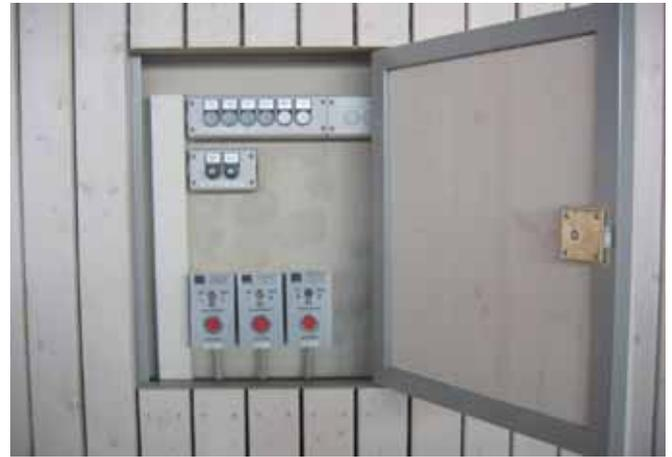
Bild 66: In die Prallwand integrierte Steuereinrichtung
