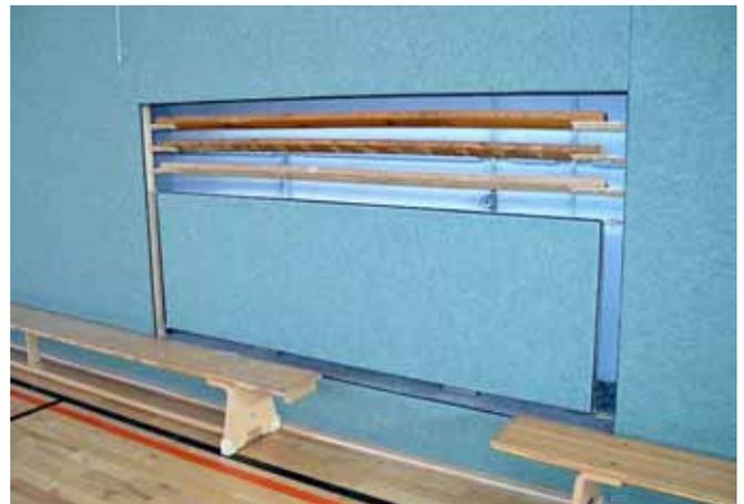
Bild 92: Nicht ebenflächig abgedeckte Heizkörper (Sanierungsfehler)
