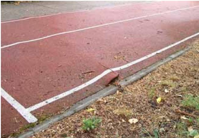
Bild 100: Durch Wurzeln unbrauchbar geworfene Laufbahnen
