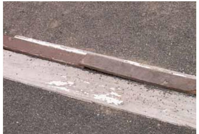
Bild 110: Schadhafter Absprungbalken bildet eine Stolperstelle
