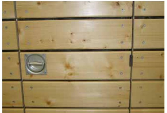
Bild 50: Beschlag einer Luke für Einbausportgeräte
