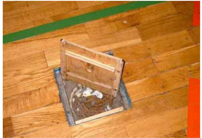
Bild 35: Korrosion unter Bodenöffnungen
