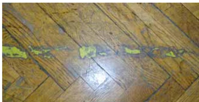
Bild 43: Reste aufgeklebter Markierungen sind nicht nur unschön, sondern bilden auch zusätzliche Unfallgefahren.
