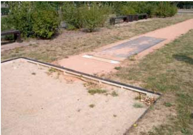
Bild 112: Wartungsmängel an einer Weitsprunganlage
