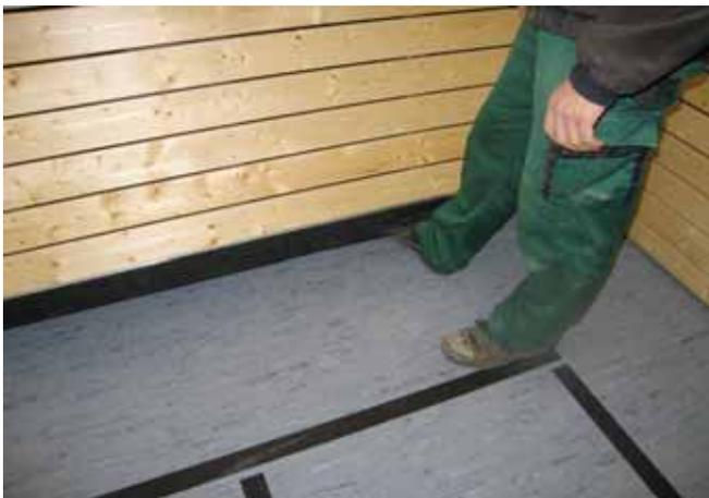
Bild 85: Ein elastischer unterer Abschluss schützt vor Fußverletzungen.
