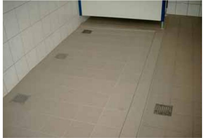
Bild 20: Trennwand mit Bodenabstand erleichtert die Reinigung.
