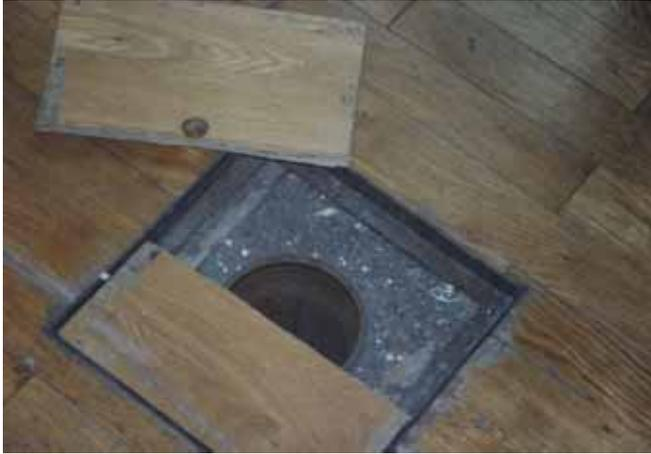
Bild 33: Quadratische Bodenöffnung für ein Steckreck ist viel größer als erforderlich.
