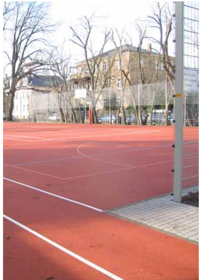
Bild 107: Kombinierte Ballfangeinrichtung aus Zaun und Netz
