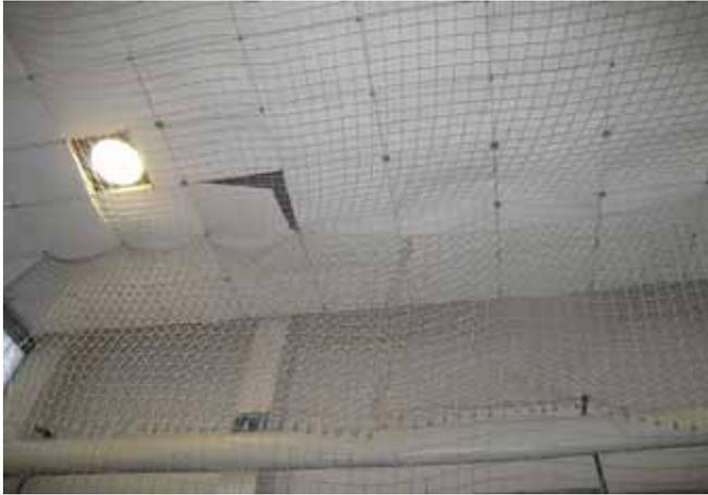
Bild 98: Ballfangnetz mit unzureichender Funktion
