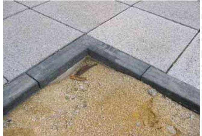
Bild 113: Betonstein mit elastischer Auflage
