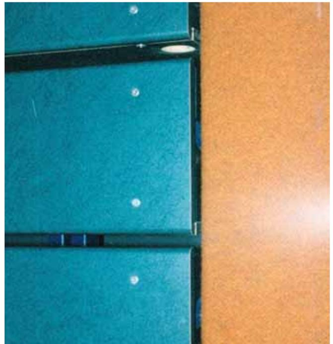
Bild 94: Tribüne mit senk- und waagerechten Fugen im eingefahrenen Zustand
