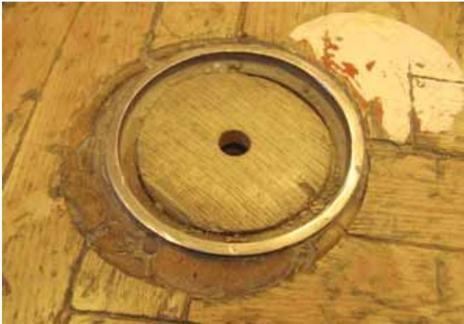
Bild 38: Notinstandsetzung zur vorübergehenden Weiternutzung
