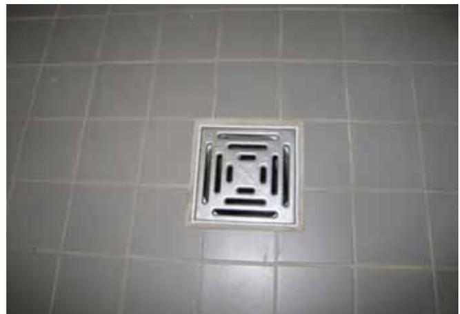
Bild 26: Geeigneter Bodeneinlauf
