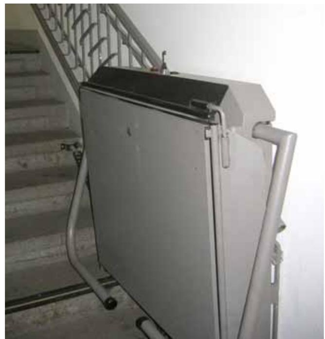
Bild 16: Überwindung von Höhenunterschieden mittels Treppenlift
