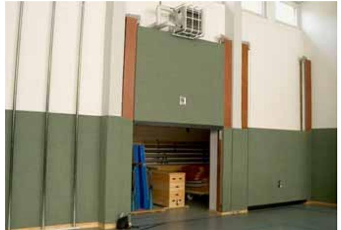
Bild 67: Hochziehbare Geräteraumtore
