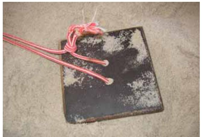
Bild 114: Ankerplatten zur Befestigung von Spielfeldeckmarkierungen
