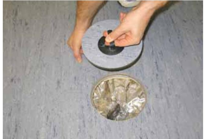
Bild 31: Herausheben eines Bodendeckels mit Sauger
